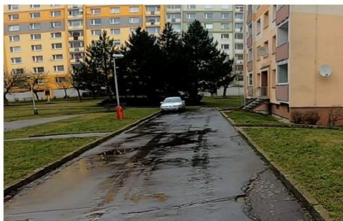
Obrázek 41: Příklad rizikového parkování na nástupních plochách pro požární techniku
