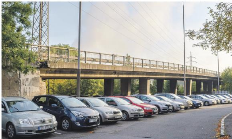
Nadjezd čeká kompletní rekonstrukce. Auta po něm budou jezdit až v září.
